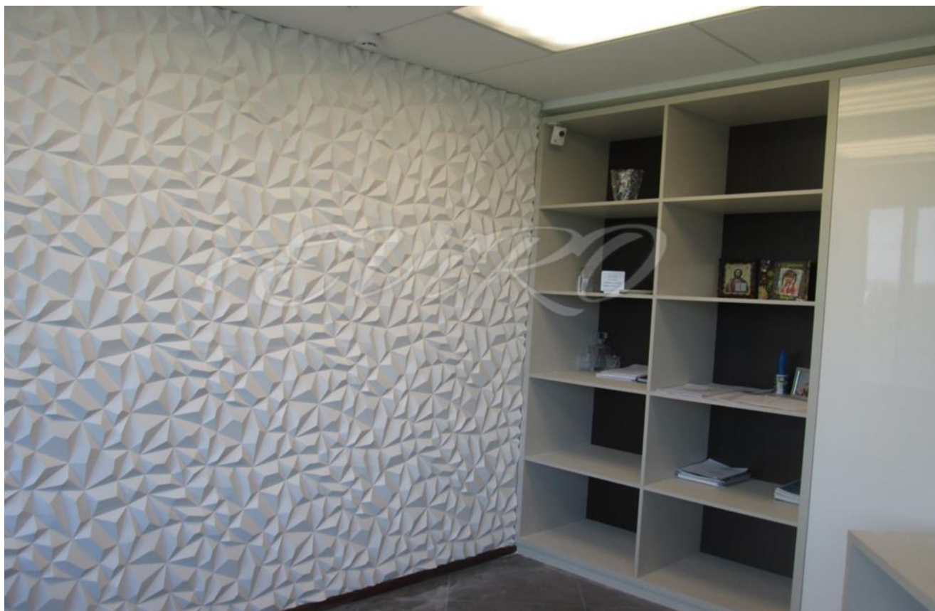
Рис. 7 Выполненный монтаж Гипсовых 3d панелей ЕВиРО
