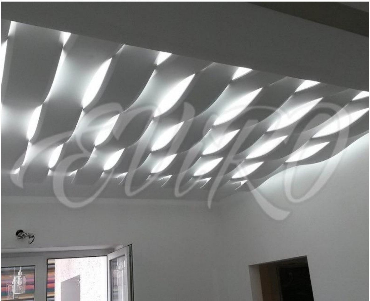
Рис. 12 Выполненный монтаж Световых гипсовых 3d панелей ЕВиРО
